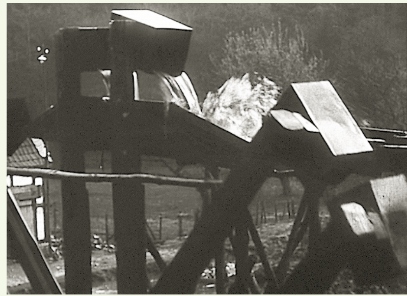
Das Wasserrad in Großaufnahme. Es handelt sich um ein kombiniertes Rad, das die Wasserkraft nicht nur für den Antrieb der Wäsche wandelt, sondern außerdem das Prozesswasser auf ein höheres Niveau in einen hölzernen Kanal schöpft.
